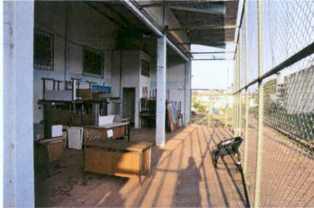
Imagem 7: Edifício da educação Foto: Marcelo Christovão, MPF/MS.
